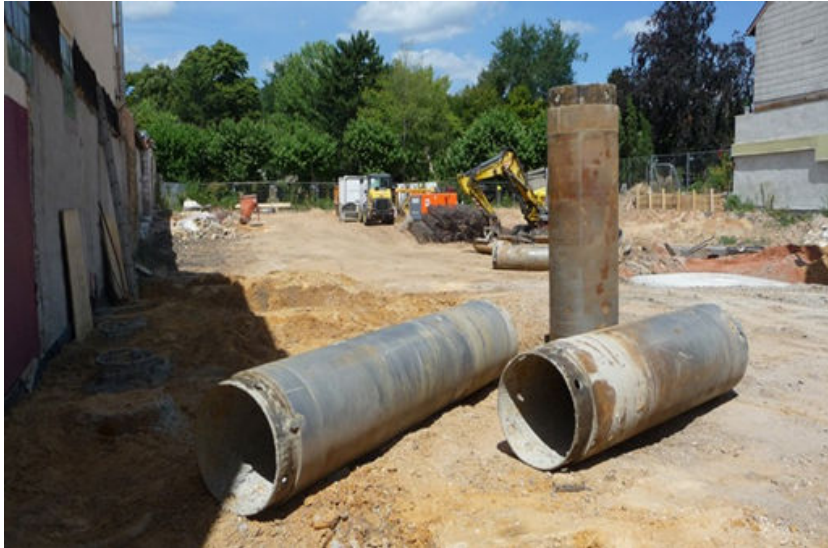
▣ Abb. 117: Unscheinbares Chaos: die Baustelle
