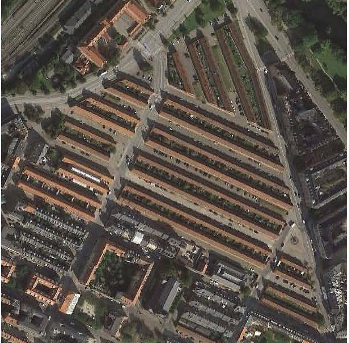
▣ Abb. 110: Ehemaliges Marine-Wohnquartier Nybodergården aus dem 17. Jahrhundert in Kopenhagen (Dänemark) (Quelle: Googlemaps dtd. 08.09.2017)
