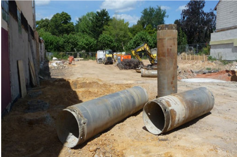
▣ Abb. 117: Unscheinbares Chaos: die Baustelle
