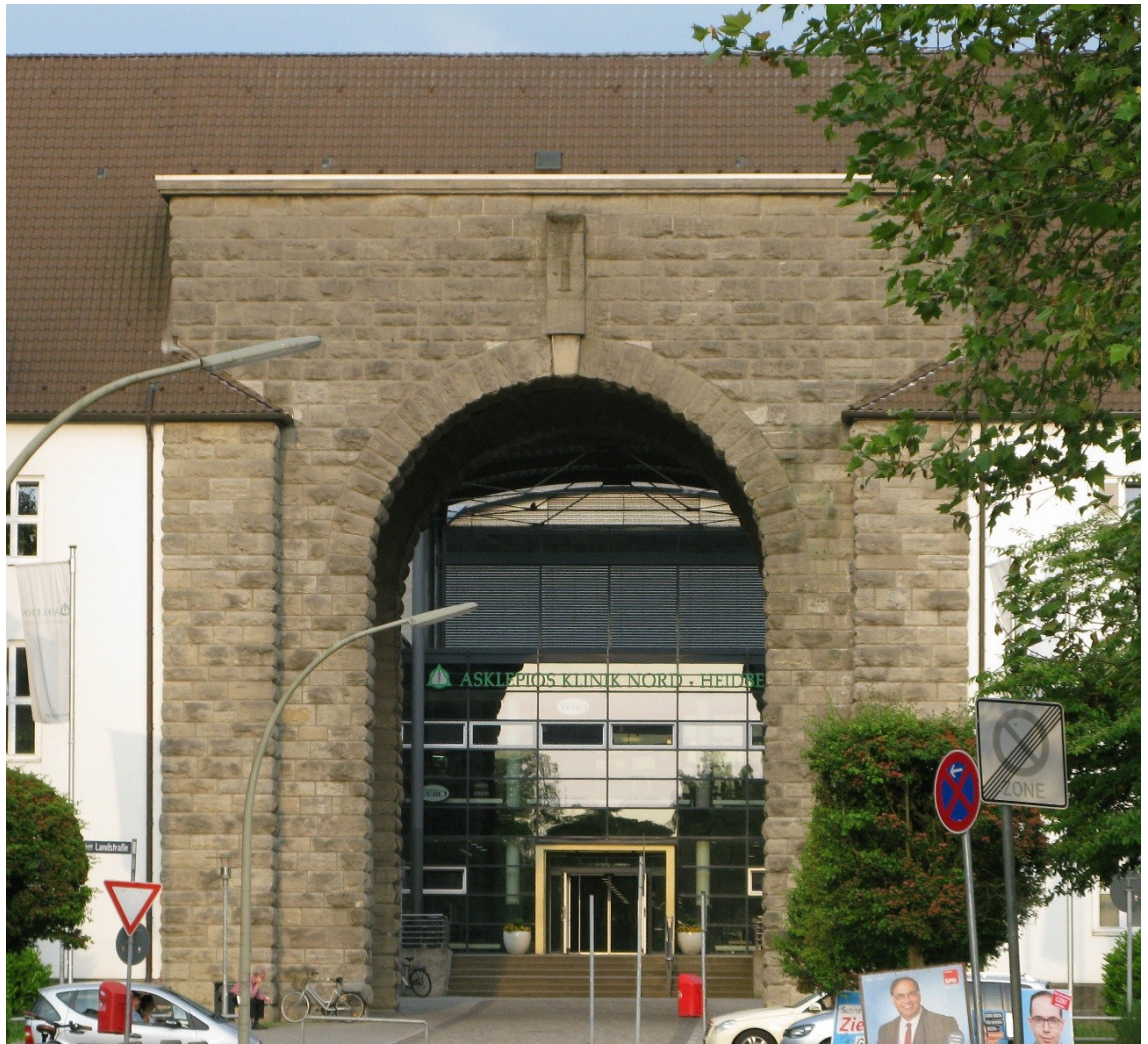
Abb. 91: Architektonisch unangemessene Monumentalität als gewollter (politischer) Architekturausdruck – Eingangsbauwerk zur ehemaligen SS-Kaserne (1937 – 1938)
