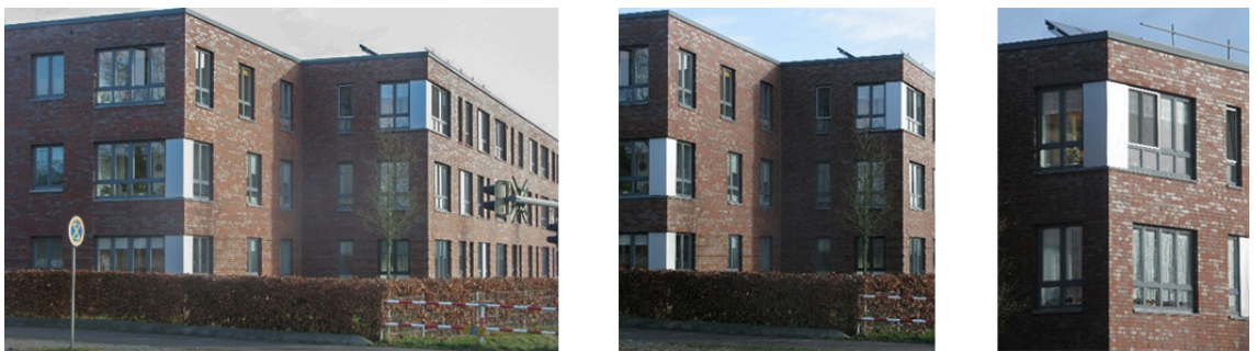
Abb. 113: Gebäude-Ecken in der Ratzeburger Allee in Lübeck
