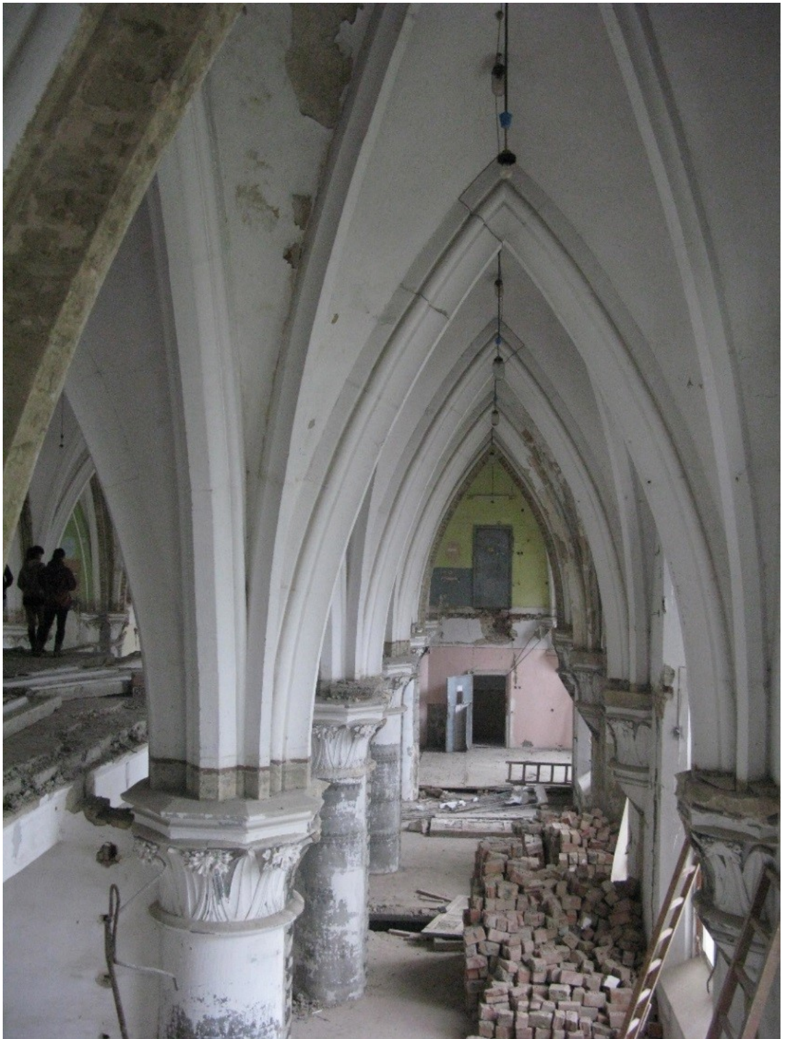
Abb. 28: Herz-Jesu-Kirche in Chernivtsi (Ukraine); Zustand Oktober 2014 bei den Abrissarbeiten des vormaligen Stadtarchivs, das zur sowjetischen Zeit dort eingebaut war.
