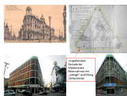
Abb. 20: Eine Zeitreise des „Edificio [Haus] Luciano Costa“ in Recife / Brasilien..... 54
