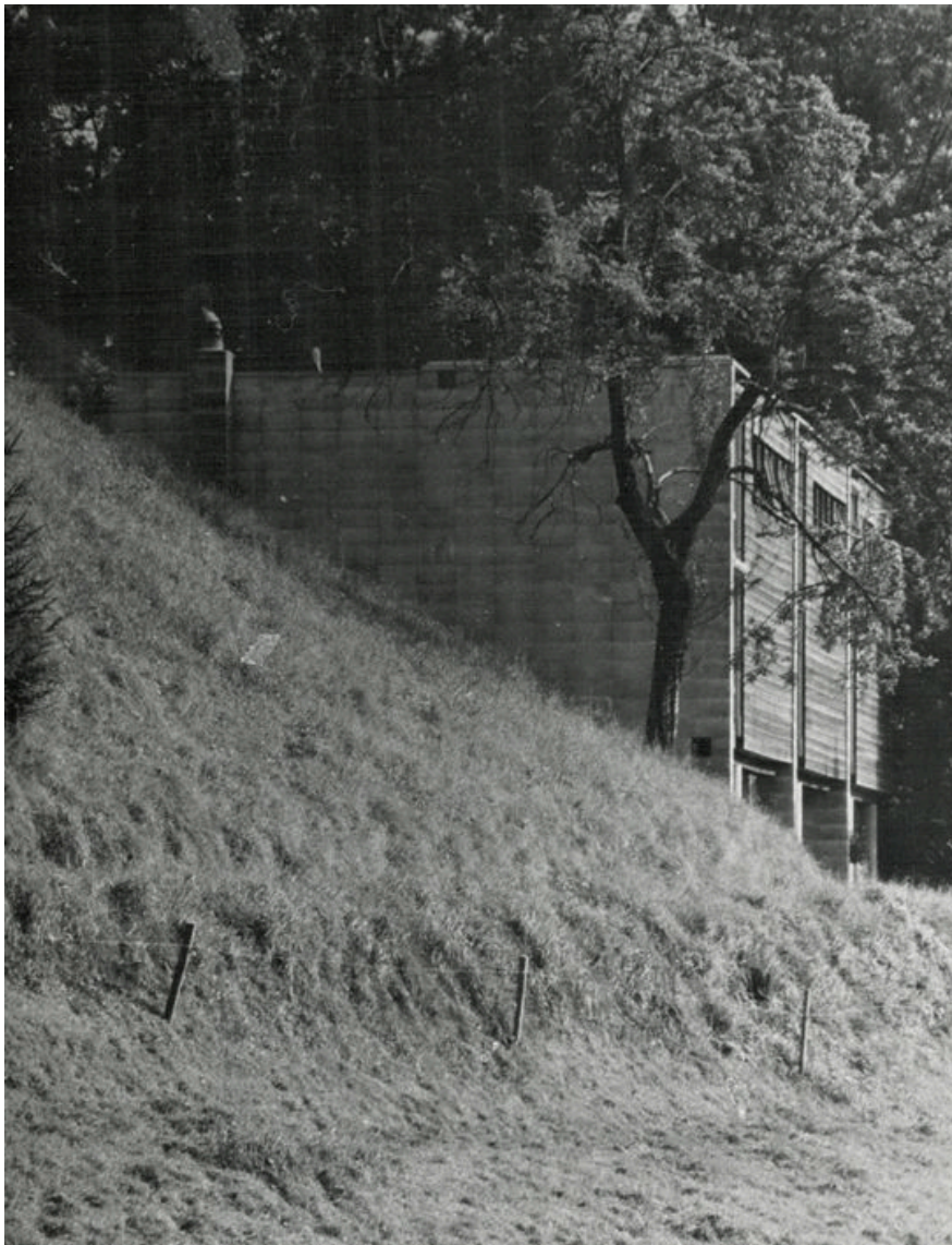
▣ Abb. 127: Seitliche, noerdliche Ansicht mit Zuweg im Vordergrund (Foto Nr. 363-14)
