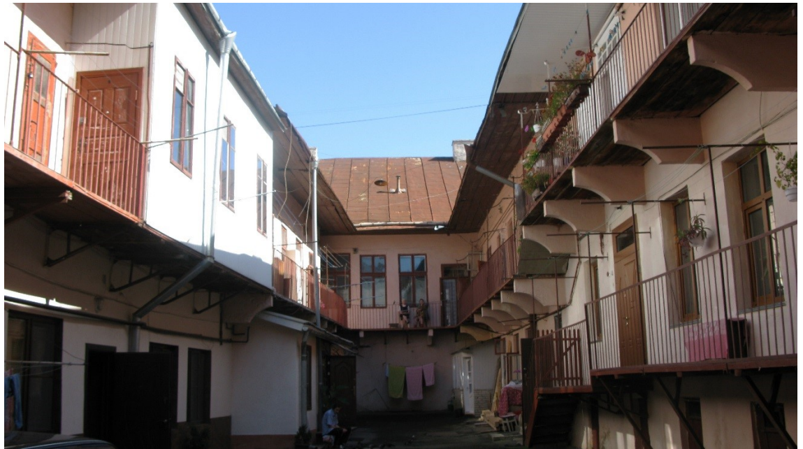
Abb. 54: Wohnhof eines historischen Zinshauses (19. Jahrhundert) in der Innenstadt von Chernivtsi / Ukraine Zugang von der Strasse her durch ein Vorderhaus hindurch
